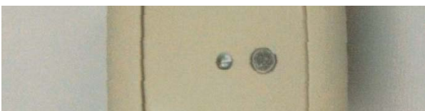
Sonderbau von Kombisensoren, in den Schalterelementen integriert
